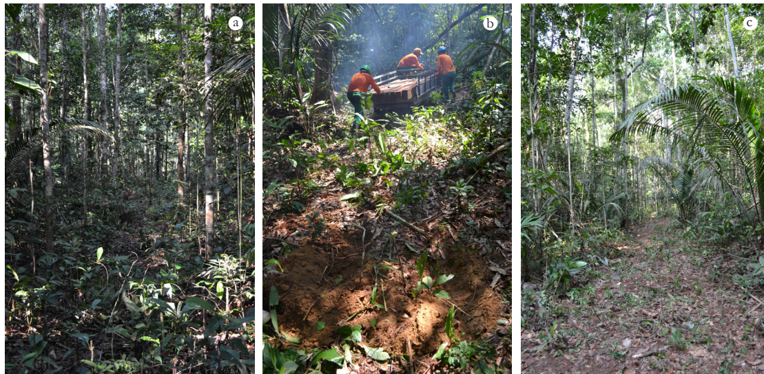
Figura 8: Condição do ramal antes (a), durante (b) e depois (c) da atividade de transporte.
